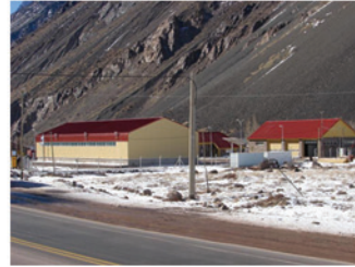
Campamento de vialidad Accampamento Stradale
